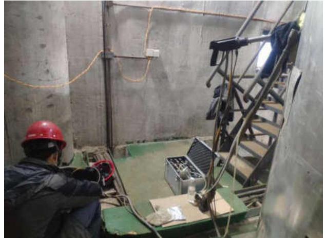
2#排气筒 DA002（◎2）有组织排放废气
