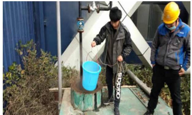
锅炉房冷却水排口（DW002）（★2）废水
