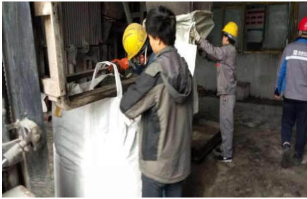
固化后飞灰堆放点（■1）固体废物
